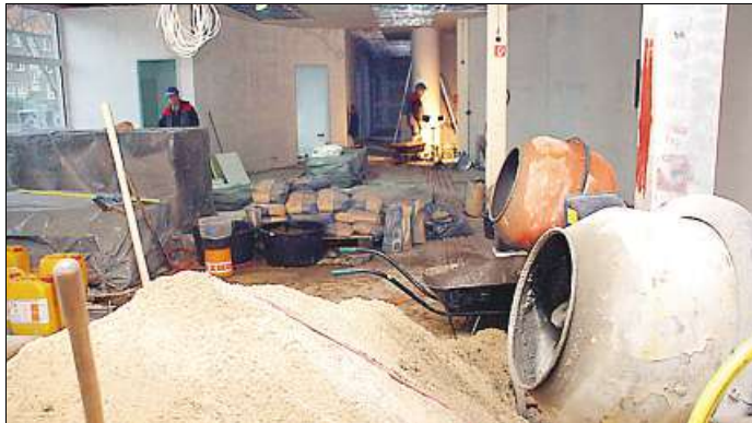
Die Mischmaschinen laufen im Dauerbetrieb: Der Estrich wird gegossen.
