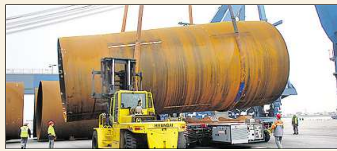
Bei Steelwind in Blexen werden große Stahlfundamente für Windkraftanlagen hergestellt, die auf See zum Einsatz kommen.
